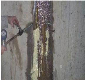
**SOF FOAM** es una resina para inyección de poliuretano acua-reactiva sin disolventes que reacciona de forma rápida formando una espuma semiflexible de célula cerrada al entrar en contacto con el agua.
