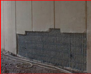
Se elimina el hormigón deteriorado por los agentes agresivos
