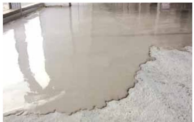
Soleras para suelo radiante de bajo espesor
