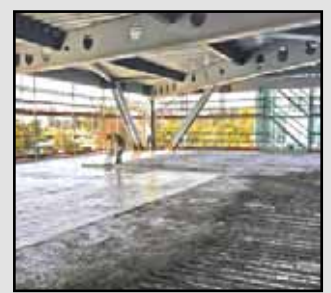
1 Hormigón estructural ligero. 2 Armadura.
