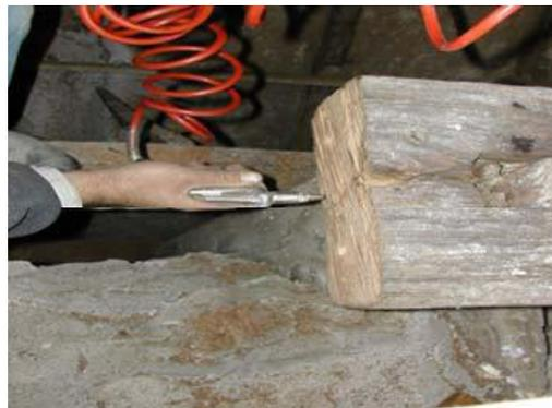
3. Inyectar en las perforaciones el anclaje químico bicomponente tixotrópico a base de resinas epoxy **RES FIX EP**. Inserción en fresco de las barras de fibra de vidrio de alta resistencia a la corrosión **ROD GRAPHENO**, compuestas por fibras de vidrio unidireccional empapado con resinas sintéticas.
