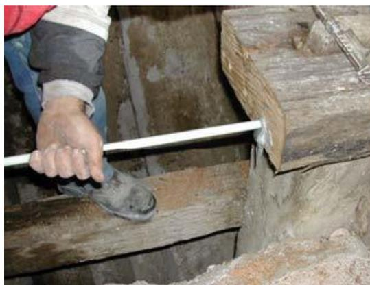
4. Formación de un encofrado perdido de madera de la misma dimensión de la viga a reparar y vertido de argamasa epoxídica constituido por resina fluida de dos componentes sin disolventes **OLY RESIN 20** amasada en relación 1 a 5 con árido de cuarzo **SOF FILLER**.
