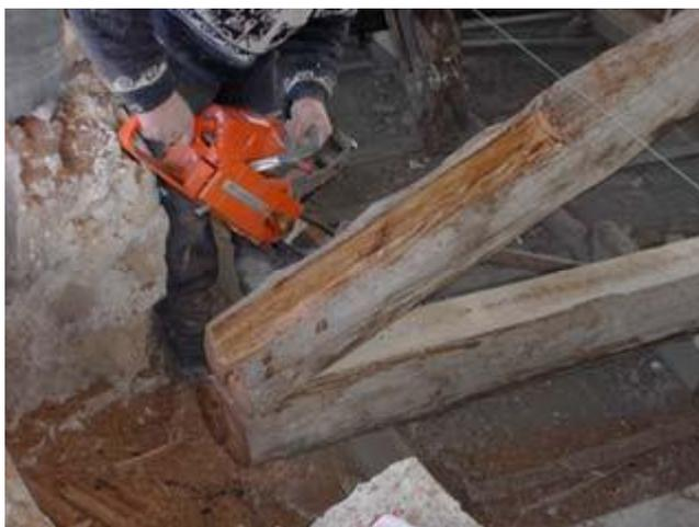
1. Apuntalamiento donde sea necesario de la estructura, con eliminación de todos los materiales que se encuentran en las zonas de intervención. Demolición de la albañilería adjunta a la viga de madera, en el caso de que la parte a reconstruir y/o reforzar coincidiera con el apoyo en la albañilería.
