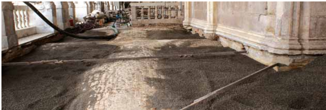
Relleno ligero de las bóvedas con Laterlite Plus 3-8- Basílica Palladiana – Vicenza – Italia
