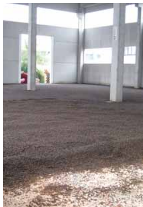
Aislamiento sobre el terreno de nave industrial Bolonia, Italia
