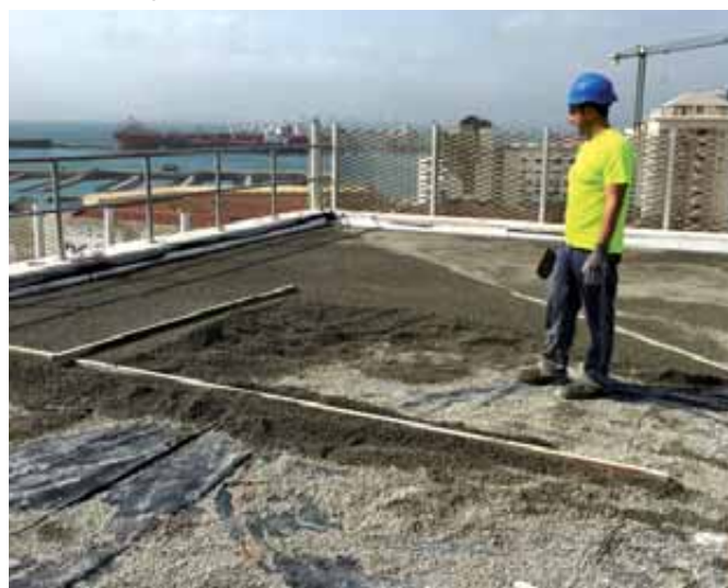
Aislamiento y pendiente de cubierta con Latermix Cem Classic – Gibraltar
