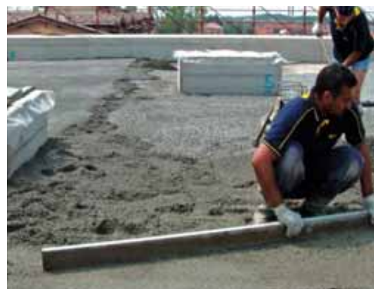
Extendido de Latermix Cem Mini.
