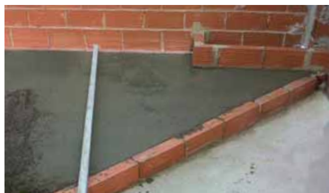
Extendido de Latermix Cem Mini.
