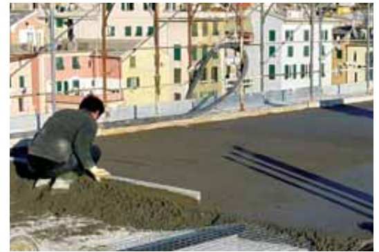
Hormigones súper-ligeros de estructura cerrada.
