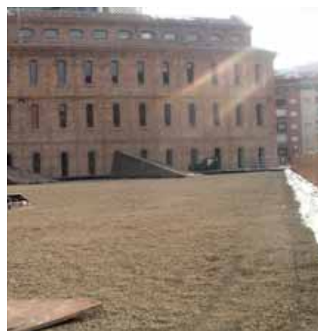
Complejo 9 de Octubre – Valencia – España. Collocacion de la capa drenante en Laterlite Agri.
