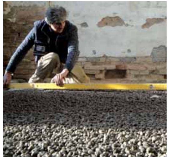
Rehabilitación de planta baja: Extendido de la capa de Laterlite Plus 8-20 en seco.
