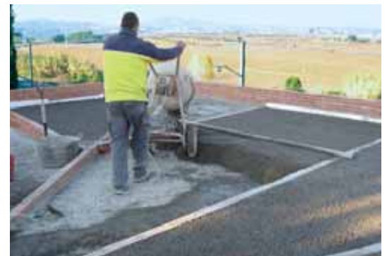
Pendiente ligera aislante con hormigón poroso
