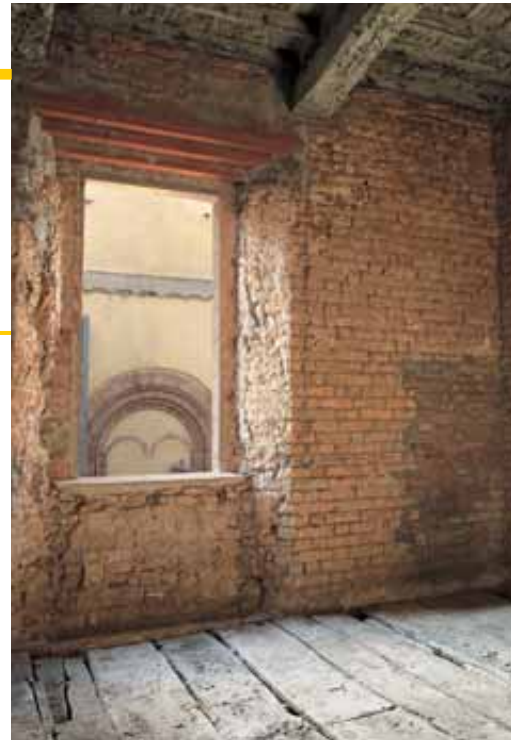
Rehabilitación de forjado antiguo - Lodi - Italia
