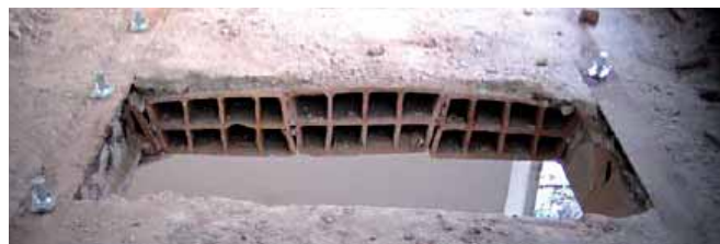
Forjado con viguetas y bovedillas cerámicas.
