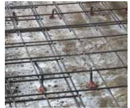
Conector mecánico artesanal fijado con resina.
