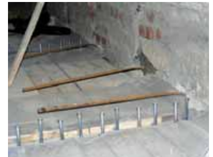
Barras de acero fijadas en la pared antes del vertido del hormigón ligero.
