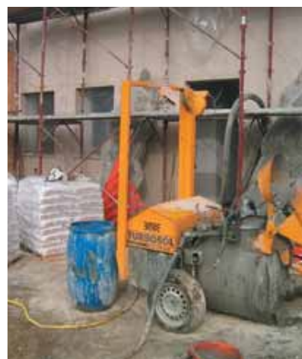
Amasado de Latermix Beton en transportadora de morteros (Bomba neumática de morteros).
