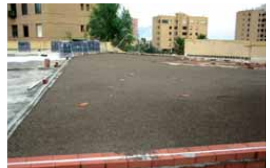
Extendido de la arcilla en seco
