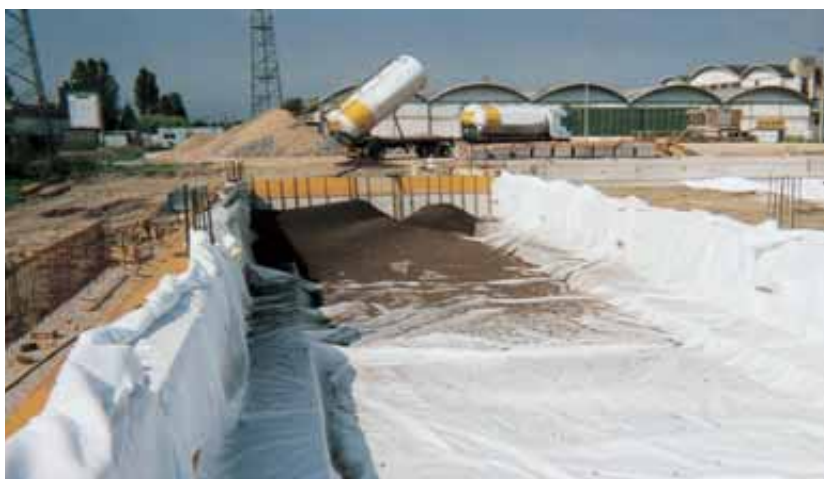
Relleno de Arcilla Expandida antes del vertido de una losa de cimentación – Milán, Italia
