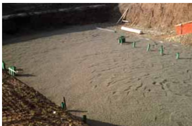
Laterlite Plus en seco puesta en obra antes del vertido de la losa de cimentación.
