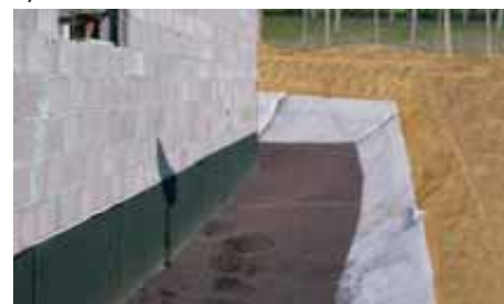
Relleno aislante de trasdós de muros de sótano Lyon, Francia
