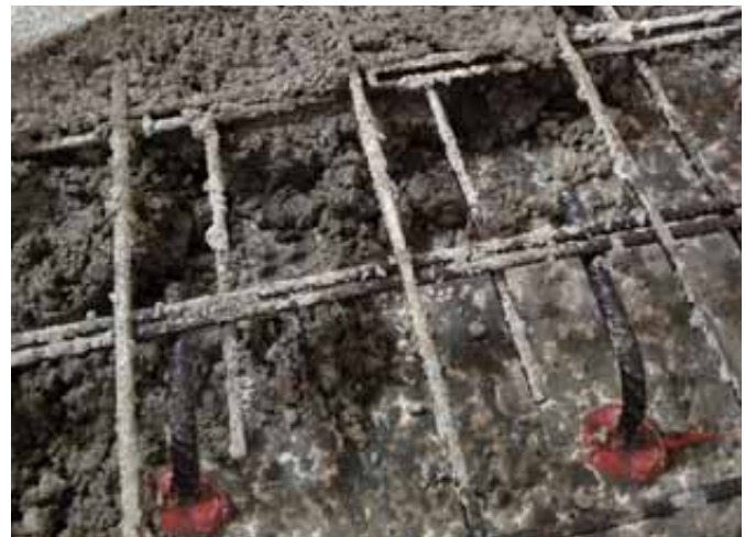
ETSI de Minas, Madrid. Refuerzo de forjado de las aulas.
