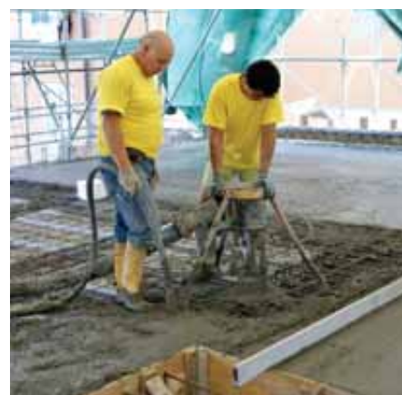
Bombeo con transportadora de mortero: trípode terminal de la manguera.
