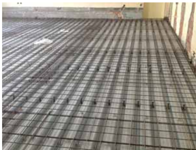
ETSI de Minas, Madrid. Sustitución total de forjado.
