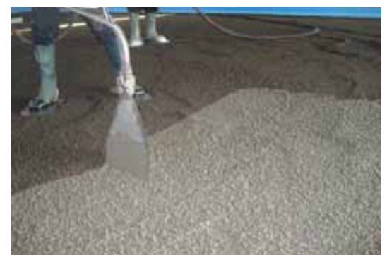
Estabilización superficial con lechada de cemento
