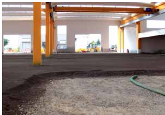
Aislamiento del suelo de una nave industrial.
