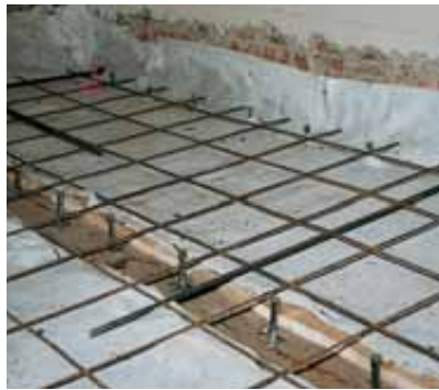
Conector mecánico industrializado tipo Tecnaría.
