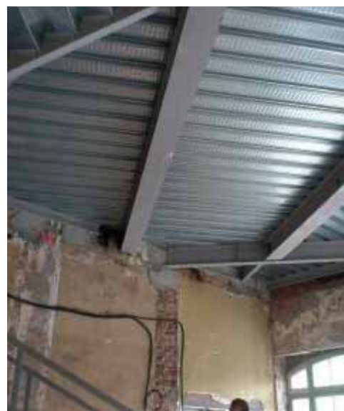
Rehabilitación: Sustitución del antiguo forjado con nueva losa mixta acero-hormigón ligero – ETSI Minas, Madrid – España.
