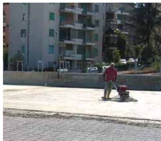
Cubierta para tráfico rodado: Capa de regularización y distribución sobre hormigón poroso ligero Latermix Cem Classic.
