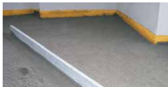
Desolidarización perimetral entre pared vertical y solera.
