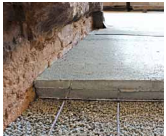
Rehabilitación de planta baja : la losa de hormigón armado sobre la capa de Laterlite Plus.
