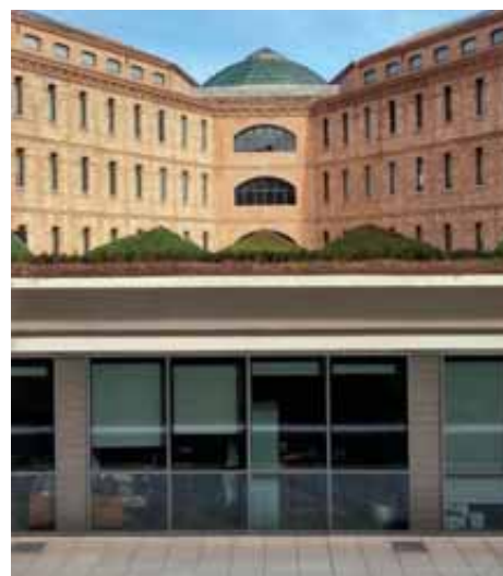
Cubiertas ajardinadas terminadas.
