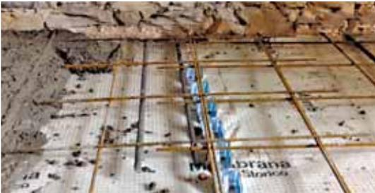
El conector CentroStorico Madera, gracias a la disposición de tornillo a 45°, optimiza el comportamiento de las fibras de madera. Trabajando principalmente en extracción, y no solo a cortante como los tornillos tradicionales, no está sujeto al riesgo perder la rigidez del vínculo con el tiempo.
