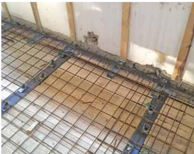
Losa sin conexión: posibilidad de deslizamiento entre las capas, falta de colaboración estructural entre antiguo forjado y nueva losa. Intervención no adecuada.
